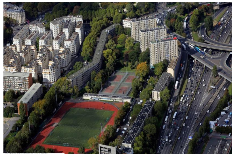
Le quartier Python-Duvernois : une façade urbaine et sportive sur le boulevard périphérique - Source : Étude urbaine, rapport de la mission 2, groupement ZCCS, 2018
