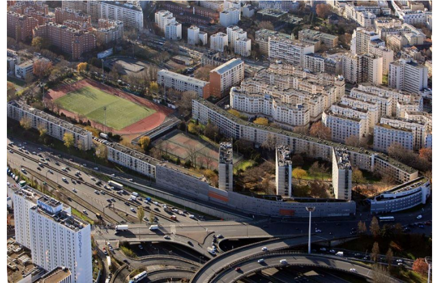
Vue aérienne du quartier Python Duvernois - Source : Mairie de Paris
