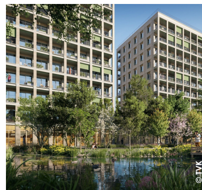
MOE bâtiment les Messageries BNP Paribas Immobilier
