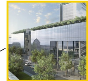
Toiture végétalisée de la Cité Judiciaire - Renzo Piano
