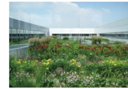
Toiture végétalisée à de forte épaisseur permettant d'abriter une partie des eaux pluviales, contribuant ainsi à l'atteinte d'un objectif zéro rejet - Strikro
